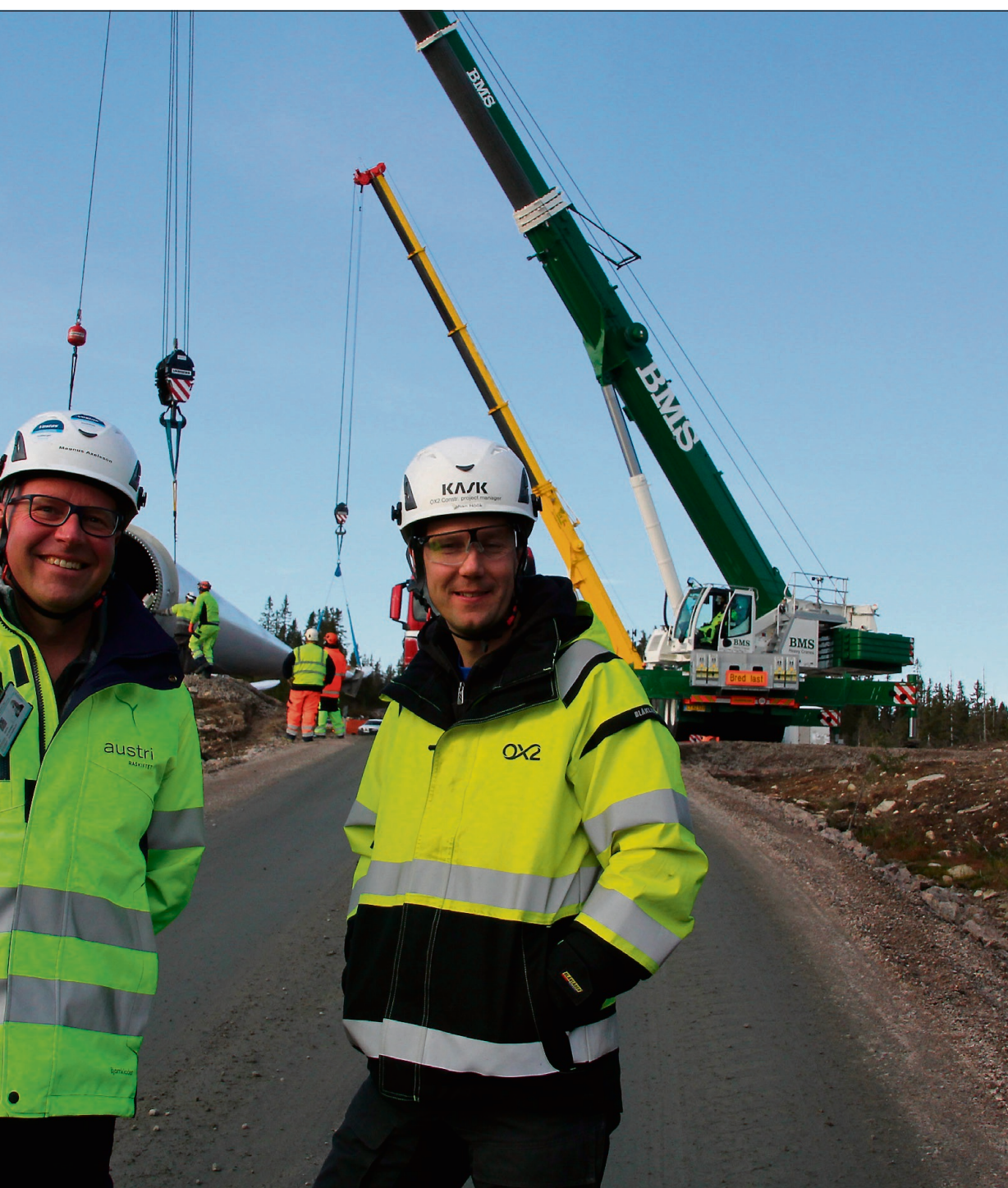
al heises opp og kjøres til turbinen. Magnus Axelsson og Johann Höök forteller at arbeidet går etter planen.
