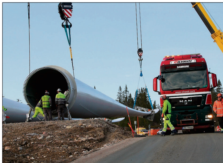
TAR TID: Det tar tid og er mye presisjonsarbeid når turbinbladene skal heises opp og fraktes til tårnet.
