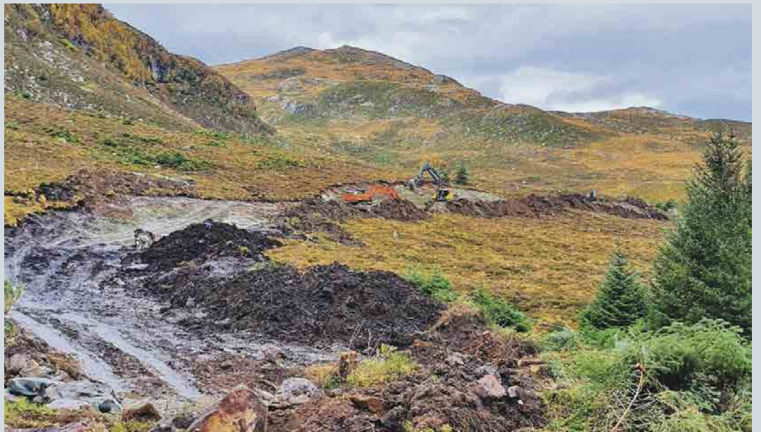
ARBEID I GANG: Hvor store må landskaps- og naturverdier egentlig være for at vindkraftindustrien ikke skal bygge det ned, spør forfatterne. Bildet viser byggingen av anleggsvei til Okla på Stad.
