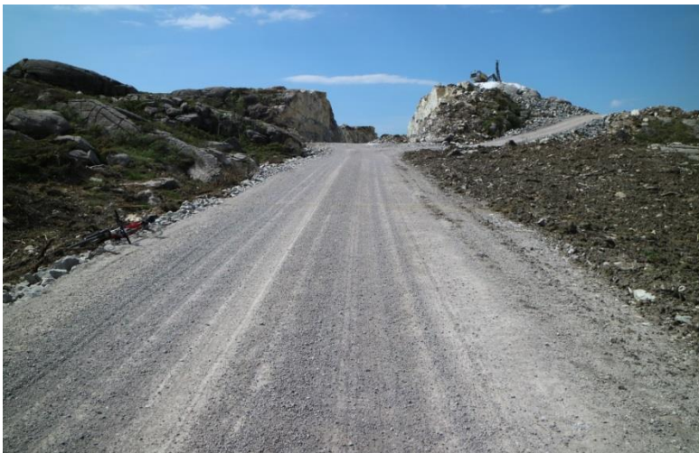
Veianlegg, Bjerkreim vindkraftverk 2018
