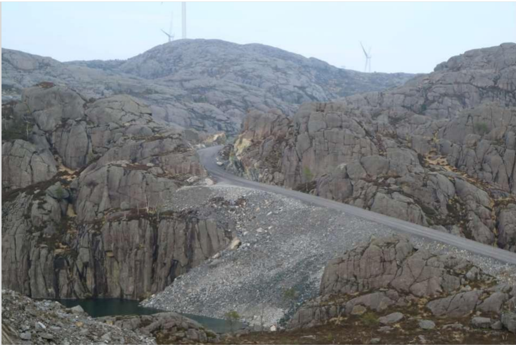
40 m høg fylling, Tellenes vindkraftverk, Rogaland
