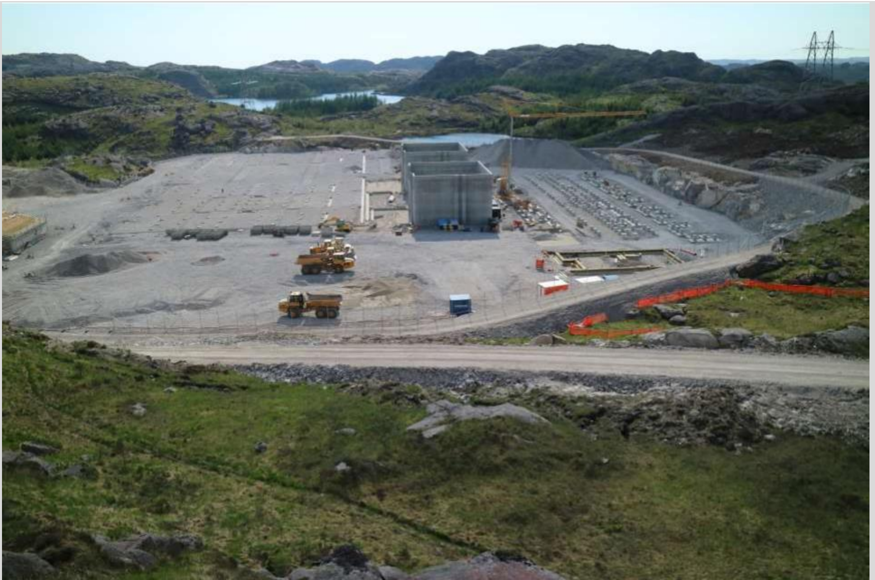
Areal for trafostasjon
