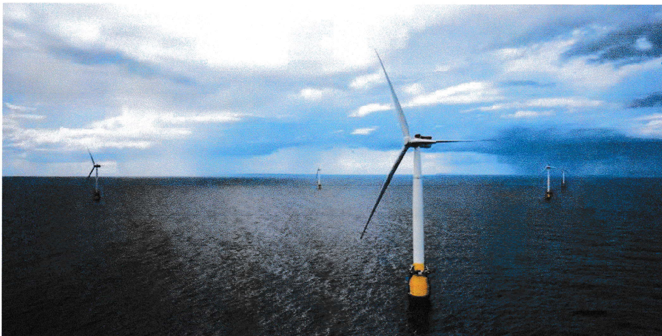
Flytende vindmøller til sjøs er mulig. Disse kalles Hywind og er eid av Equinor.
