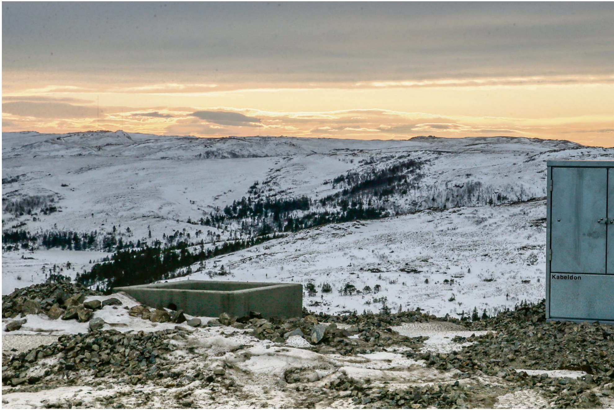
Storheia snart ferdig: Veinett og turbinplasser er langt på vei ferdig bygd på Storheia i Åfjord. FOTO: Terje Svaan
