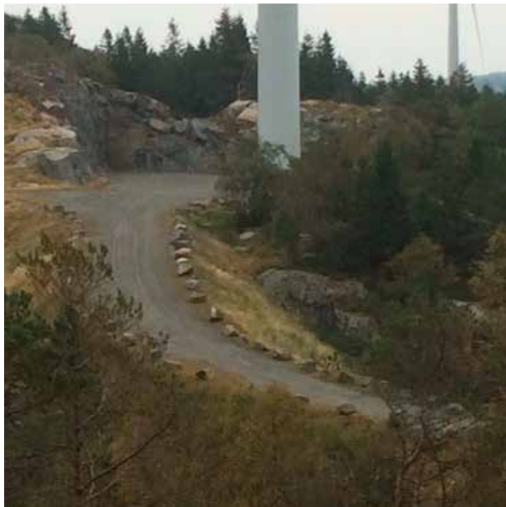
I konsekvensutredningen står det at det var sannsynlig at alle møllene ville «bli satt opp på fundamenter festet med forankringsbolter i stål og som dermed vil kreve minimalt med grunnforberedelser/utgraving». Rune Kroslid påpeker at sårene i fjellet er omfattende. FOTO: PRIVAT
