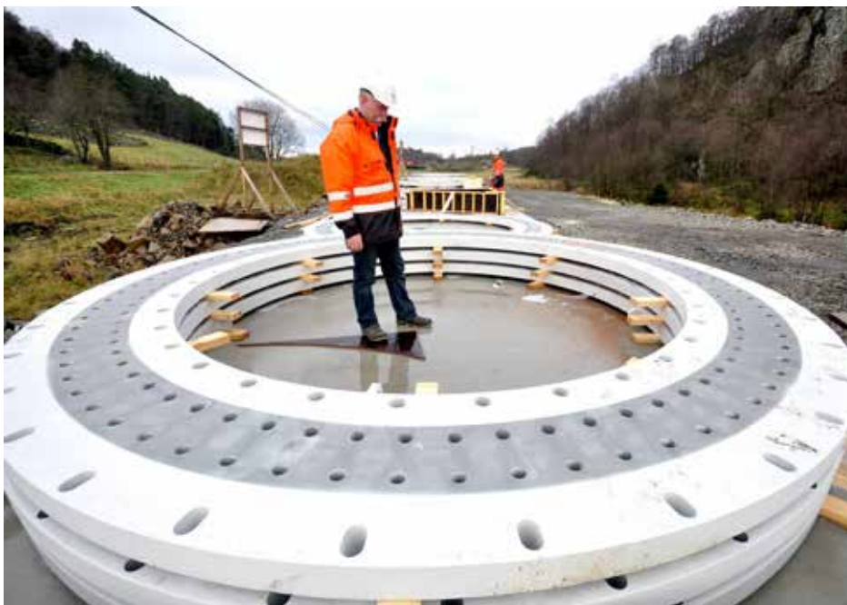
– Hvert fundament veier 11 tonn, og skal boltes fast i fjell, uttalte Tor Helge Kjellby da han viste frem fundamentene til Farsunds Avis i november 2011. FOTO: CECILIE NILSEN
