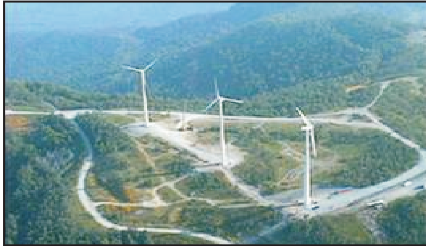
Roan vindkraftverk i Sør-Trøndelag
